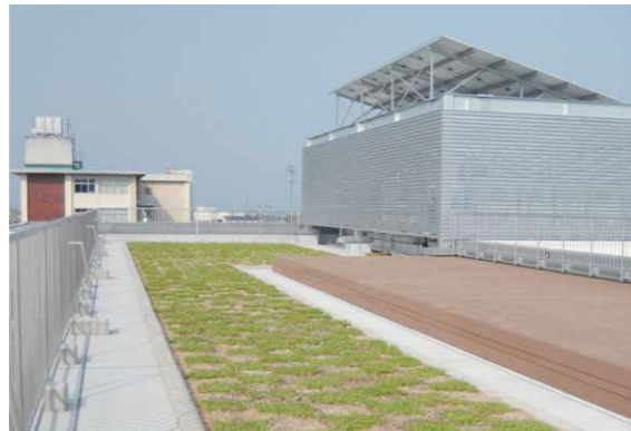
屋上緑化による熱負荷低減 太陽光発電パネル(10kW×2台)
