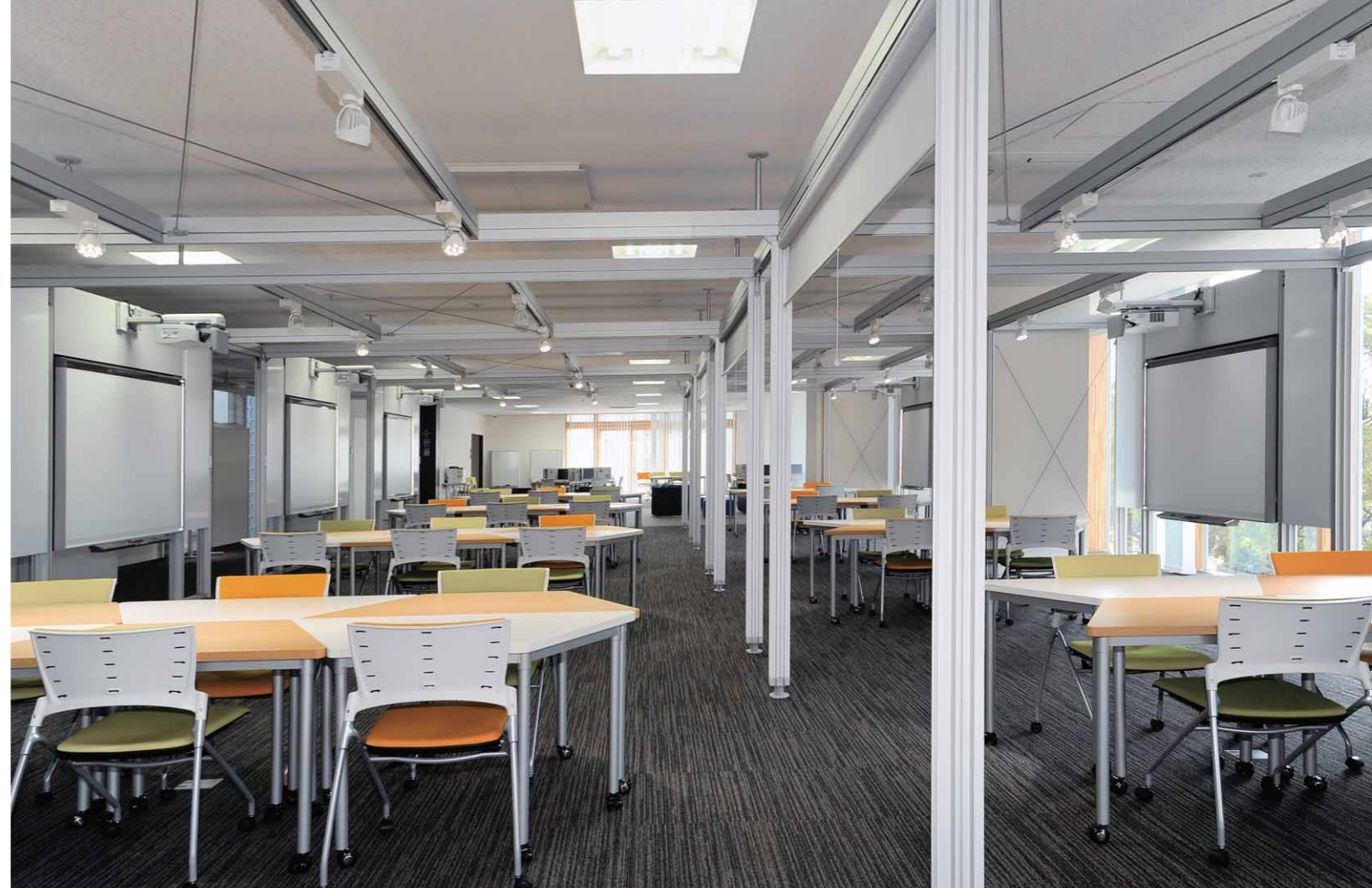
2階ラーニング・ commonsの照明 必要に応じてロールスクリーンで間仕切りできる空間は、一体形LEDベースライト埋込形スクエアタイプとLEDスポットライトを区画に対応して配置
