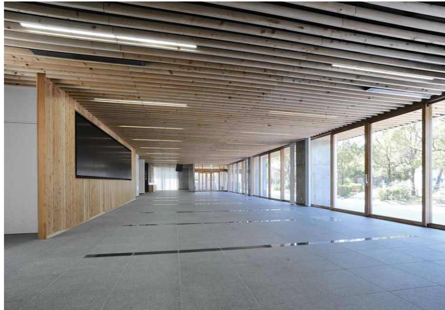
1階展示ホールの照明(1) 親しみ感、温かみのある木製ルーバー天井の内部にLEDベースライトストレートタイプを設置
