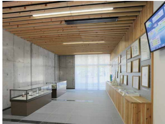
1階展示ホールの照明(2) 紫外線をほぼ含まないLEDの特性により、展示物の損傷のない照明効果を得ながら省エネを図っている
