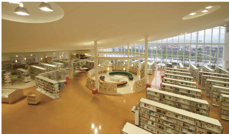
図書室のベース照明は傾斜天井に円筒状のトップライトを設け、その内部にネオセラ高天井用反射器具を採用
