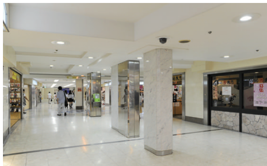
サンロードの中でも最も広い8m幅の通路のLEDダウンライト照明
