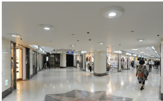
通路十字路の天井ふところはダクトが集中しているため厚みのリニューアルプレートを使用
