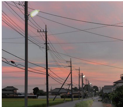
独立照明ポールに設置されたLED防犯灯
