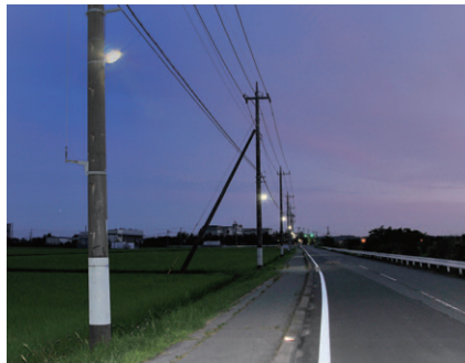
田んぼ周辺道路の共架式LED防犯灯
