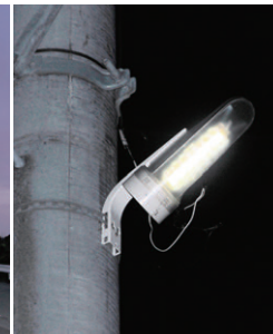
住宅地周辺道路の電柱に設置されたFL20W防犯灯から更新されたLED防犯灯
