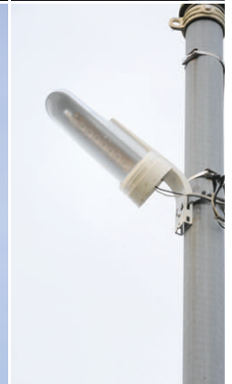
独立照明ポールのLED防犯灯
