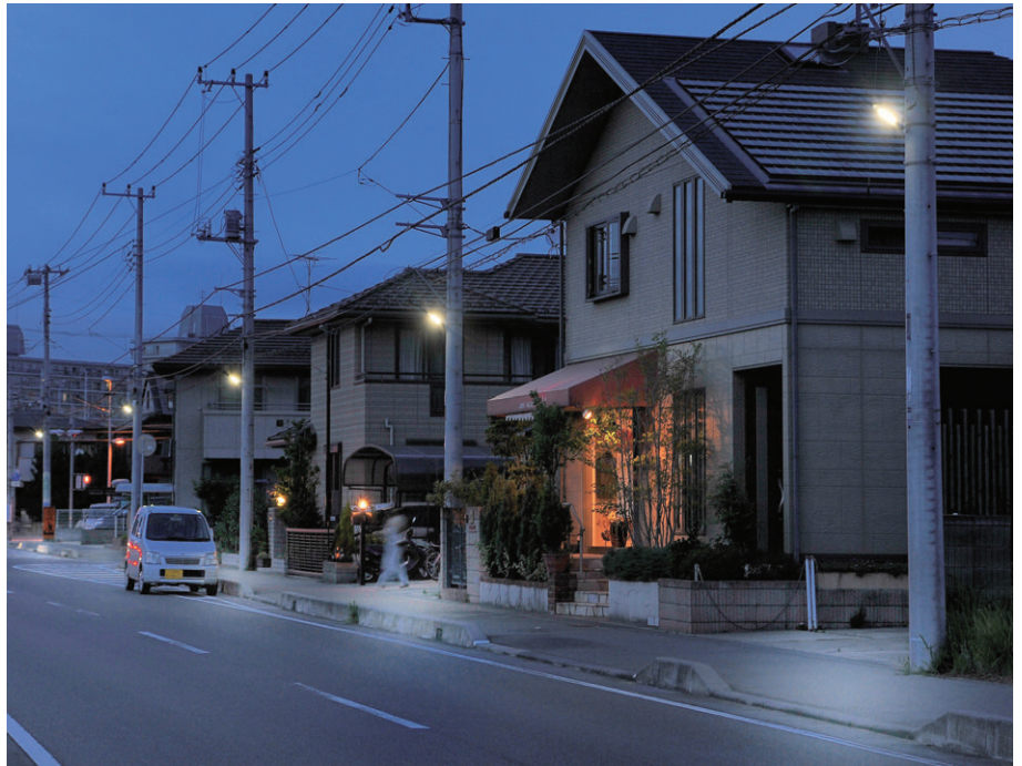
住宅地周辺道路の電柱に設置されたFL20W防犯灯から更新されたLED防犯灯
