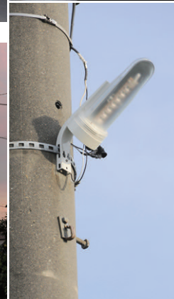
電柱に設置された共架式LED防犯灯
