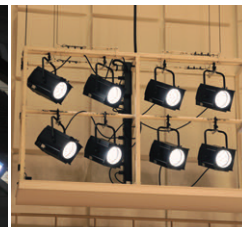
客席の両サイドに設置され、舞台を側面より照らすフロントサイドスポットライト
