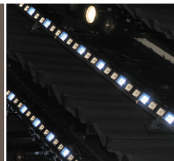
舞台上部に吊物装置により吊上げられているボーダーライト
