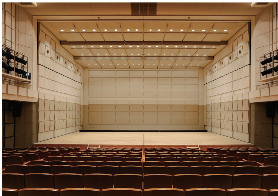
舞台音響反射板に設置されていたハロゲン天井反射板ライトをLED音響反射板ライトに更新
