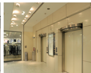
エレベーター前のLEDスポットライトによる間接照明
