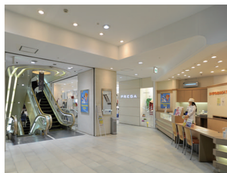
エントランス・インフォメーション前のLEDダウンライトによる照明
