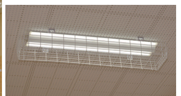
器具用ガード装備の一体形LEDベースライト薄形タイプ
