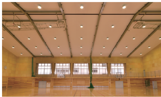
アリーナの側面から望むLED高天井器具
