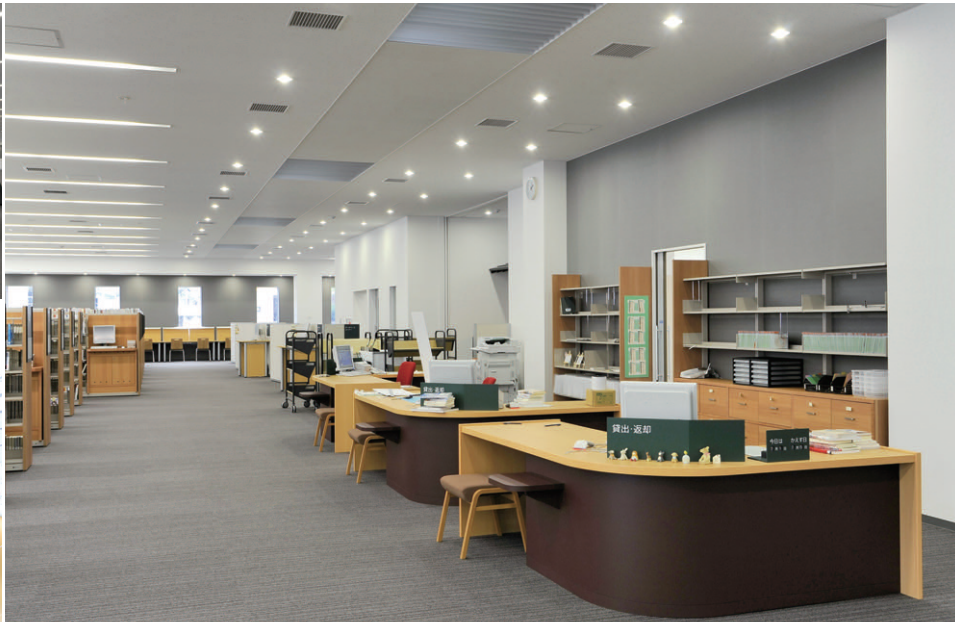
サービスカウンター周りの照明(42Wコンパクト形ダウンライトを均等配置)
