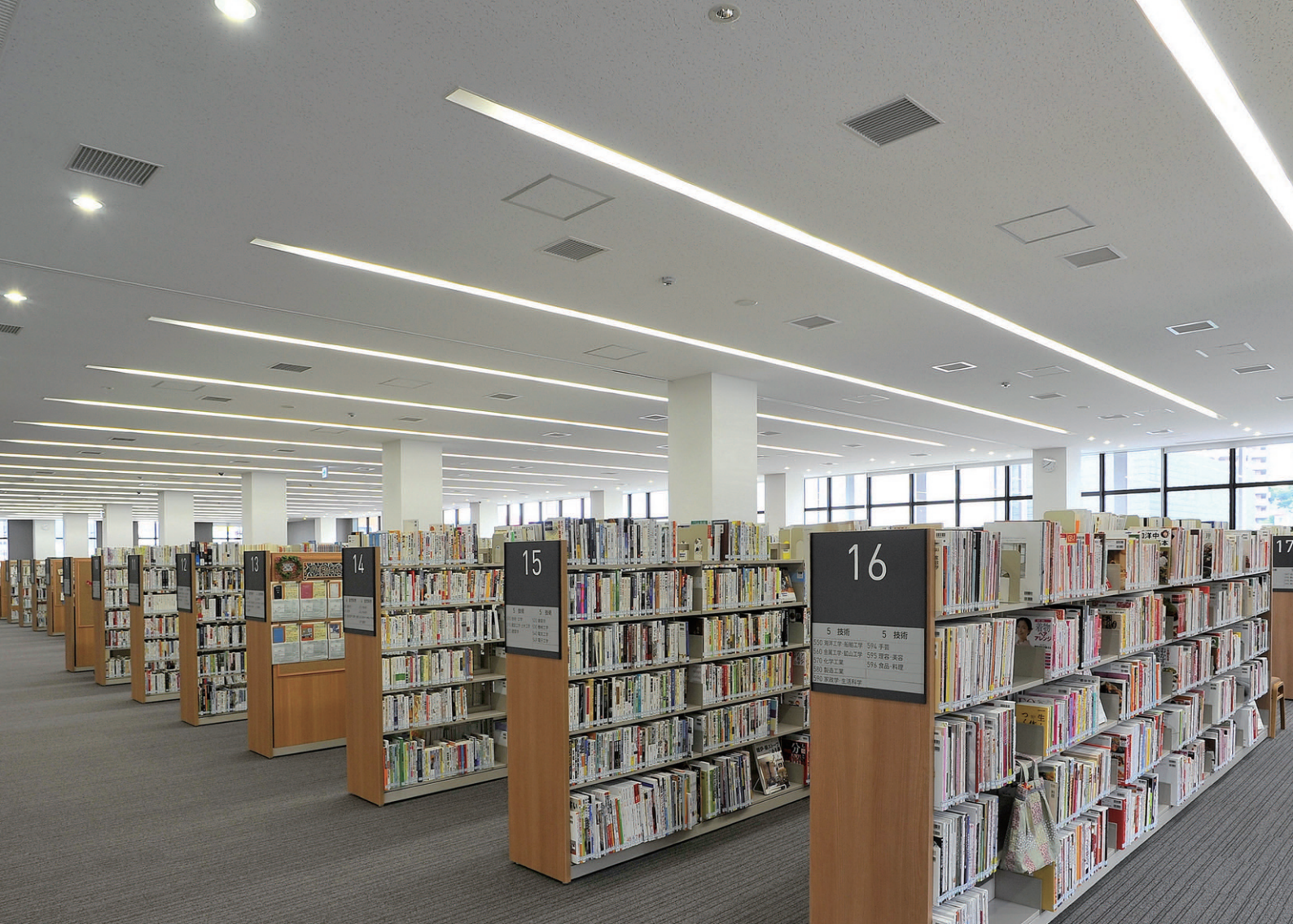
ベース照明に高出力形FHF32W×1笠なし器具連結配置を採用した図書館、書架周りの照明
