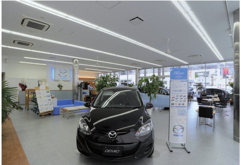
一体形LEDベースライト薄形タイプをライン配置したカー・ショールームの照明。明るく広々とした空間演出で展示車のイメージを高めている
