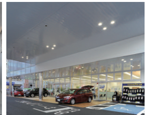
LED軒下用ダウンライトを3灯1組で配列したキャンピーの照明
