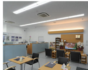
サービス工場利用者の待合スペースのLED照明
