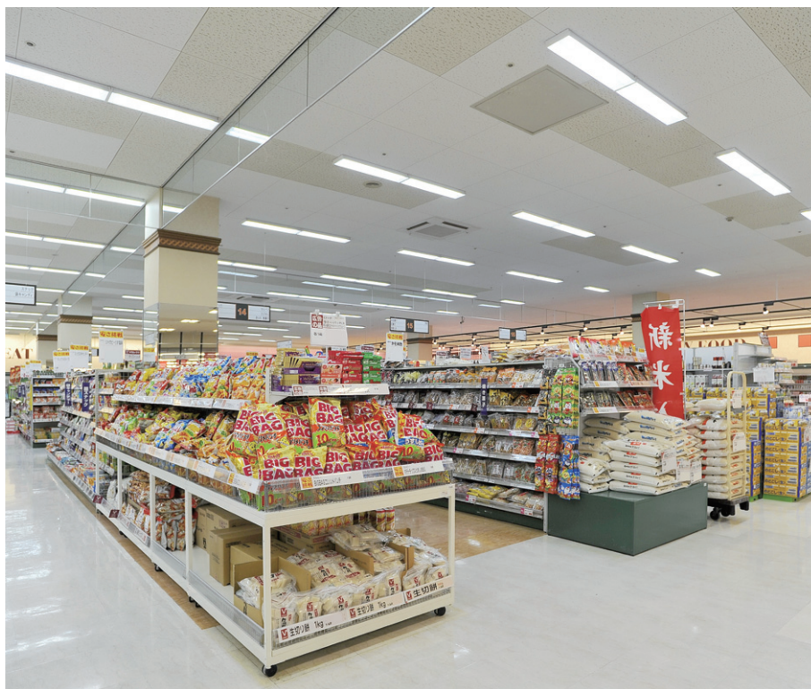
店内中央売場ゾーンの照明は一体形LEDベースライトストレートタイプを2.5mピッチでライン状に配置
