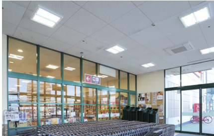
エントランスの照明は外光とのバランスを考慮し、昼白色の一体形LEDベースライトスクエアタイプを設置
