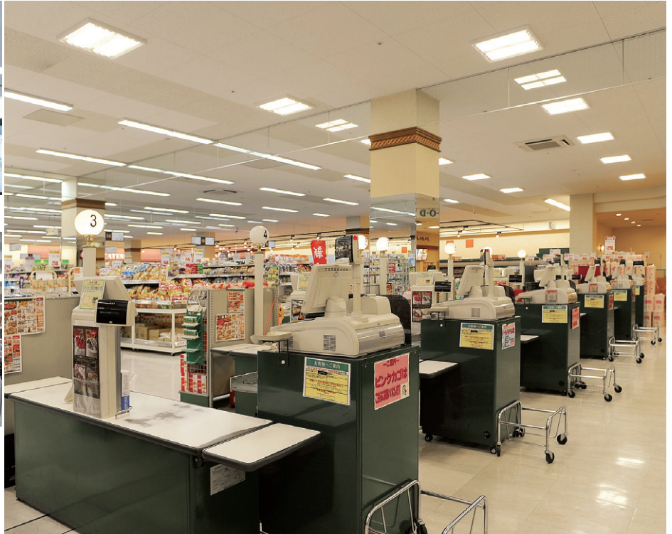
一体形LEDベースライトスクエアタイプの温白色を設置し和みある光環境としたレジ・サッカー台周りの照明
