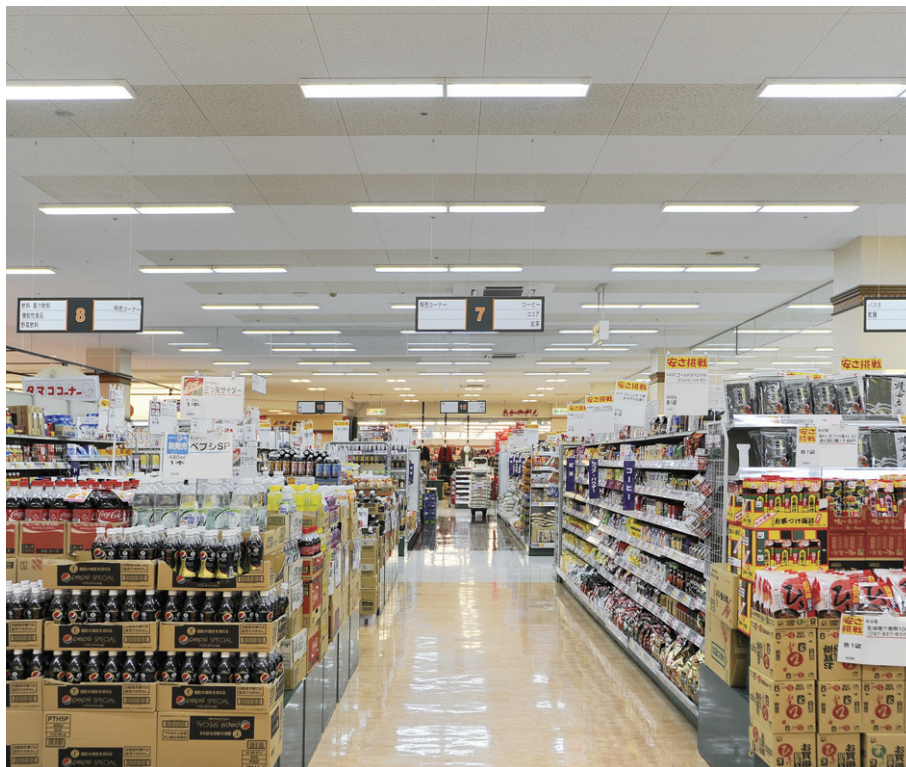
飲料水売場周辺から奥を望む。商品陳列棚とクロスに配灯し、商品の種類を見分けやすい光環境を確保
