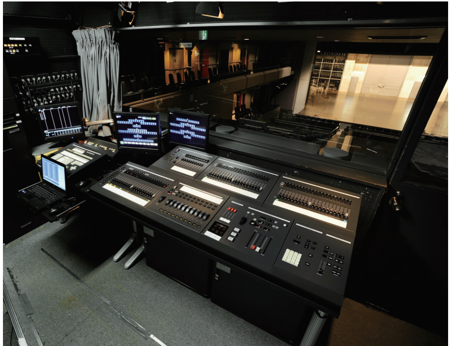
更新した調光操作卓LICSTAR-IV Type S 1ユニット10kg以下で、1人での搬送も可能
