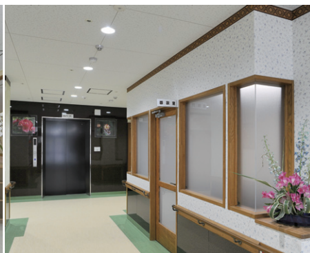
LEDライトエンジンダウンライトを用いたエレベーターホールと廊下ライトを採用
