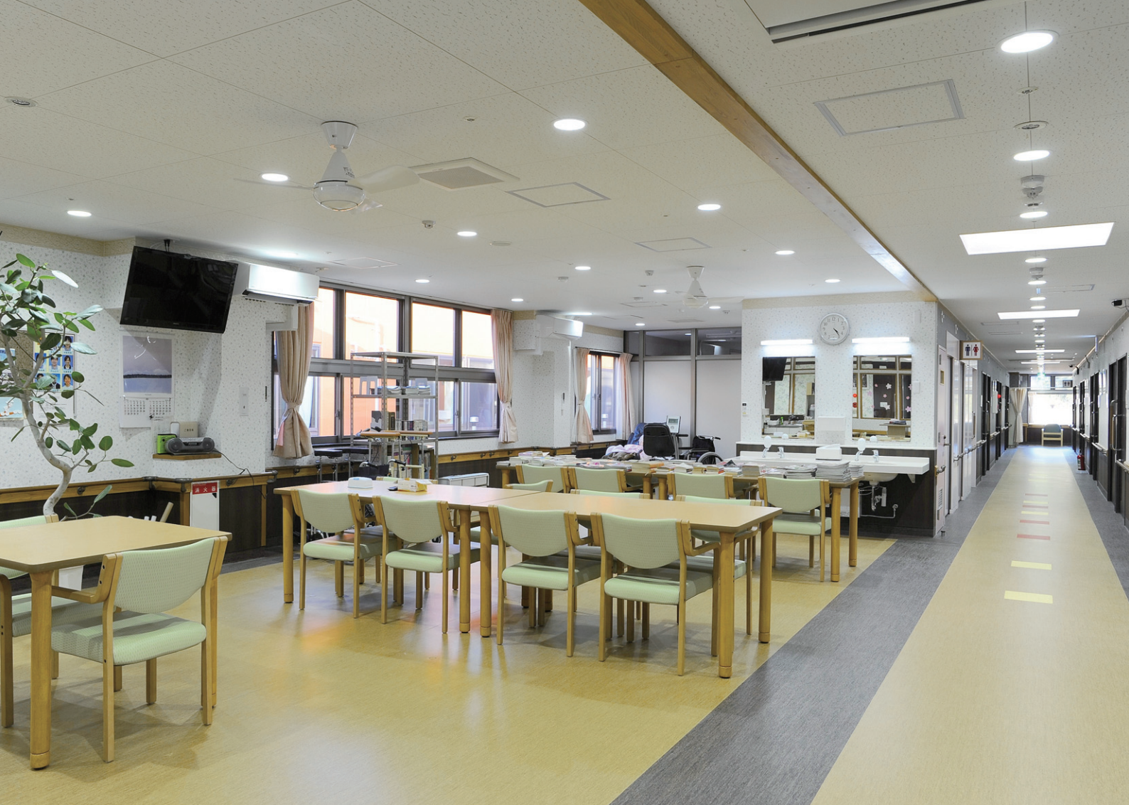
3階介護付有料老人ホームの食堂ホール 高齢による視力低下を配慮し、LEDライトエンジンダウライト電球色で高めの照度設定とし、かつ温かな光環境を確保
