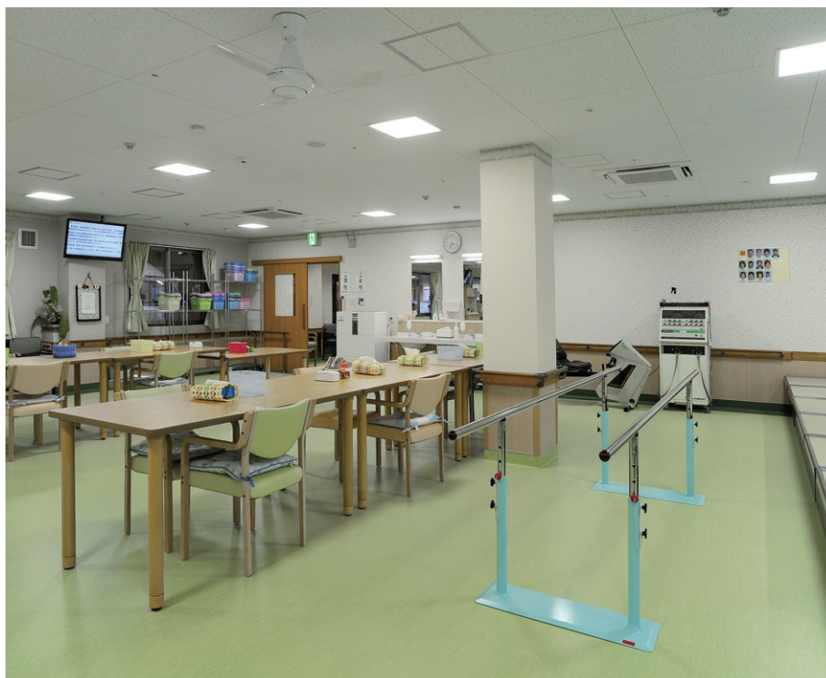
1階デイケアホールは一体形LEDベースライトスクエアタイプを採用。落ち着ける方向性のない光とともに下面カバー付を使用しグレアを抑制
