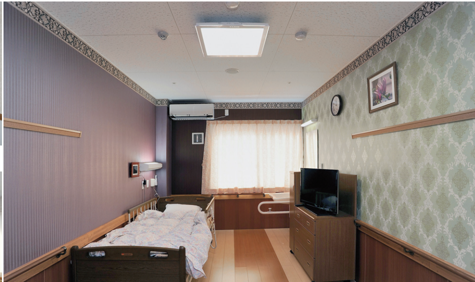
3階介護付有料老人ホームの個室の照明は天井面にも光が広がる角形LEDシーリングライトを採用。センサーにより自動で明るさを調整
