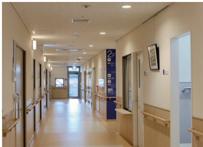
ストレッチャー等を配慮し、壁側に寄せたダウンライト
