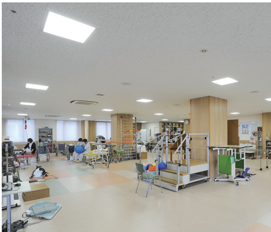
リハビリテーション室の照明 方向性のない埋込スクエアカバー付器具により均一な明るさを確保
