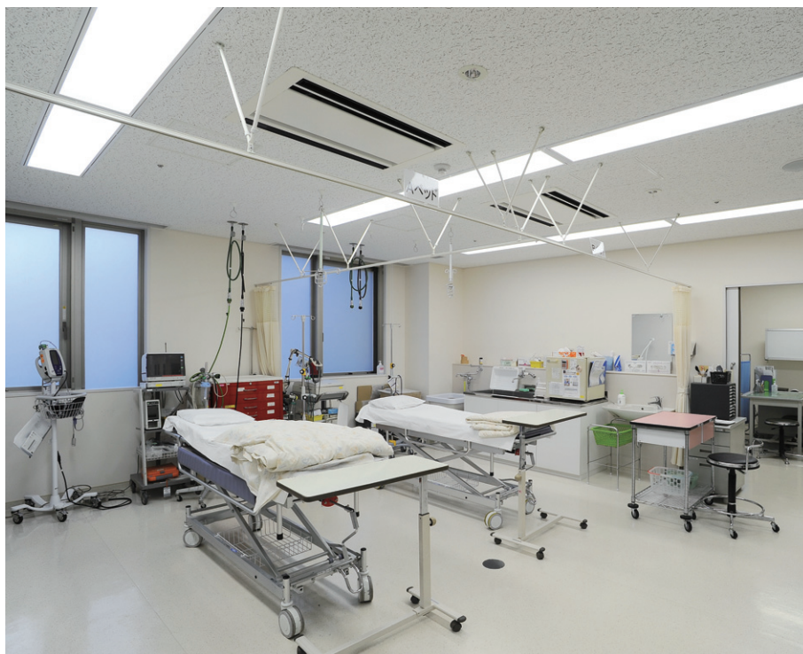
救急処置室の照明 乳白カバー付器具を治療台の両サイドに配置し、患者に眩しさを与えないようにするとともに医療スタッフの目の疲れを軽減
