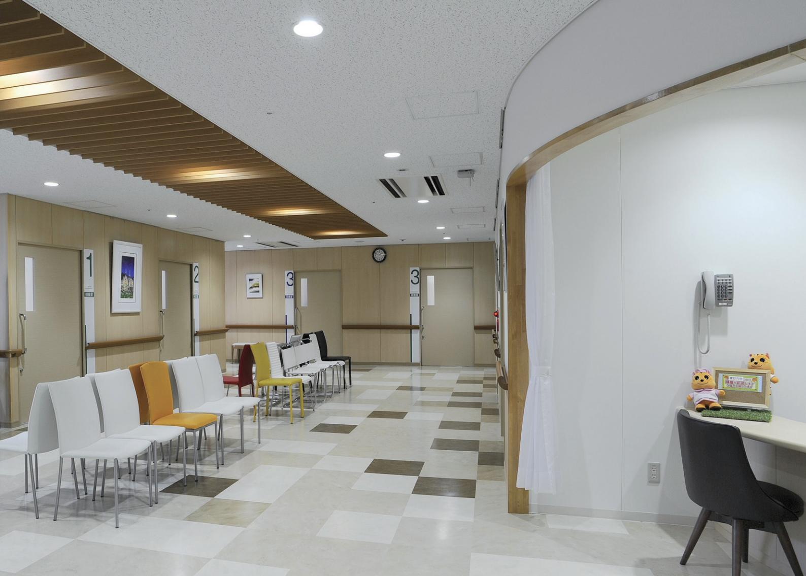
検診ホールの照明 LEDダウンライトを一部ルーバー天井内に配置し眩しさを低減。省エネを図りつつ、長寿命によるメンテナンスも軽減
