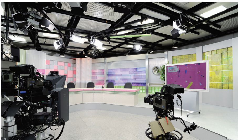
LED照明に更新されたスタジオをカメラ側から望む
