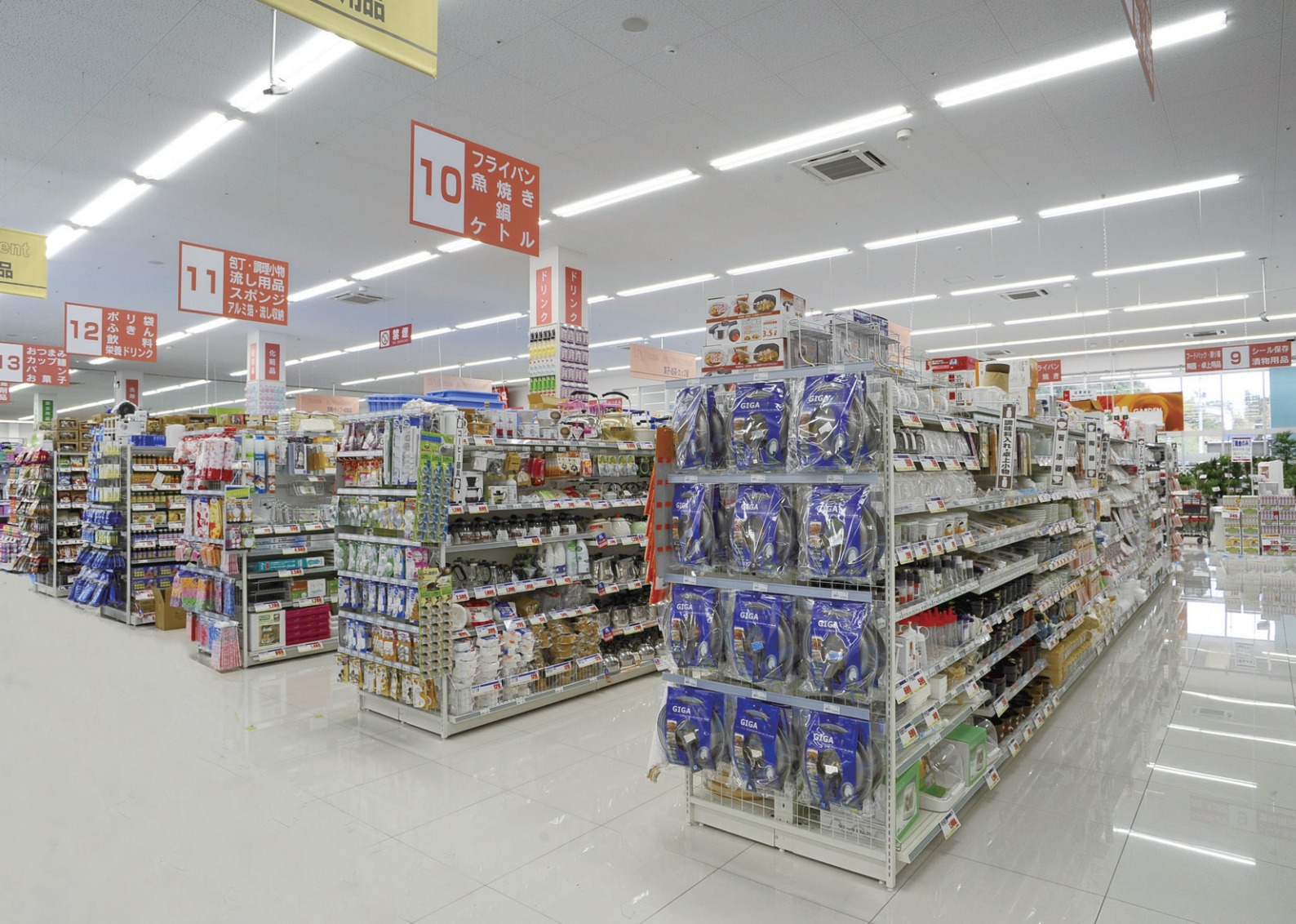
一体形LEDベースライト2295mmタイプの昼白色を採用し、商品陳列棚へ直角にライン配置。商品を見やすい、選びやすい十分な水平面照度とともに鉛直面照度も確保
