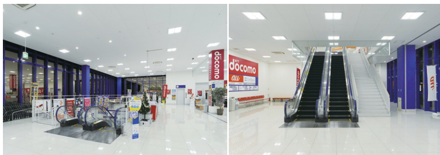
2階エスカレーターホールは指向性の高いLEDダウンライトを設置 白色で清潔感のある1階エントランスの照明
