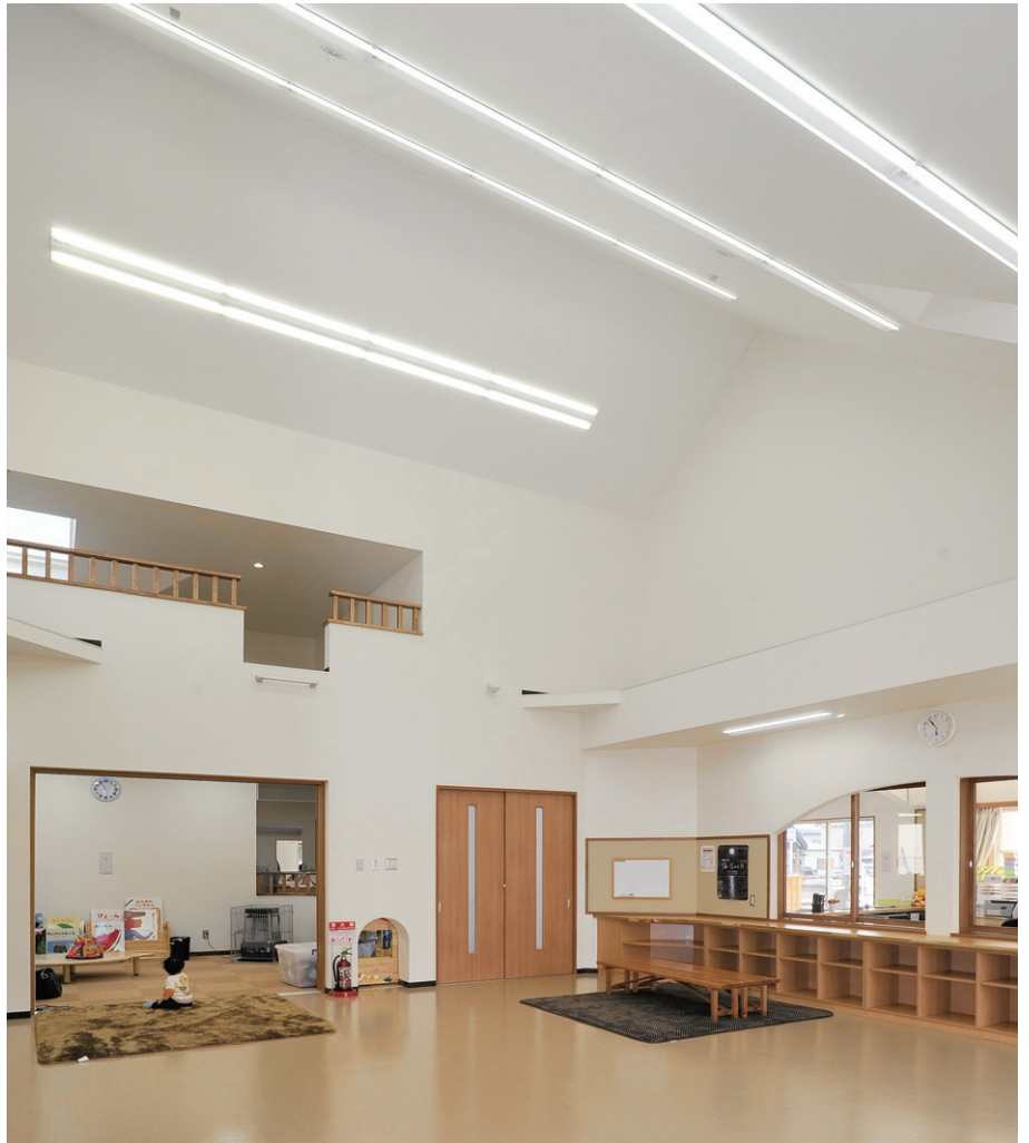
遊戯室の照明 最高約7m高の昇り天井形状に省エネ性能の高い一体形LEDベースライト直付器具薄形タイプを連結設置。昼光色の光色で明るく、さわやかな光環境を創出
