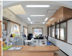
Hf蛍光灯埋込器具バツフル付を採用した事務室の照明
