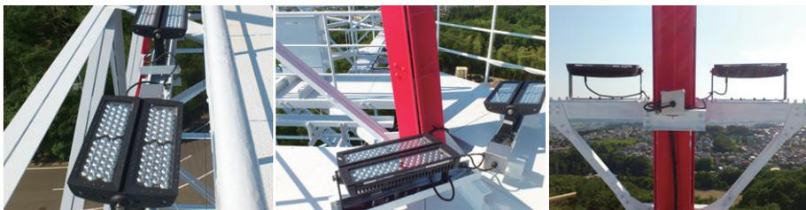
LED投光器の設置の様子 LED照明は全て上向きで点灯しているため、不快なグレアは発生してなく、また寿命40,000時間と長寿命で、高所の器具メンテナンスが困難な本鉄塔には最適
