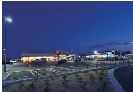
北東側より望む広大な駐車場。周縁部にはLED駐車場灯を配置
