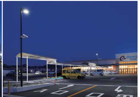
車路や歩道など照度が必要な場所に配置されたLED駐車場灯
