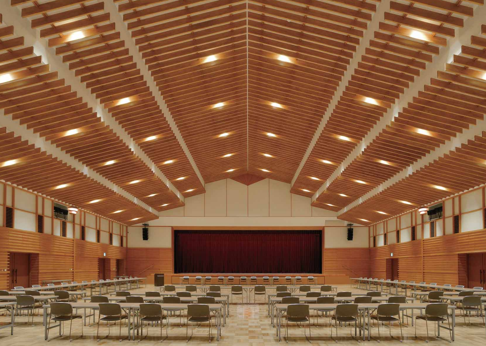
ロビー側から舞台側を望む 大講堂天井全面に木製ルーバーを用い、その間にLED一体形ダウンライト9000シリーズを設置
