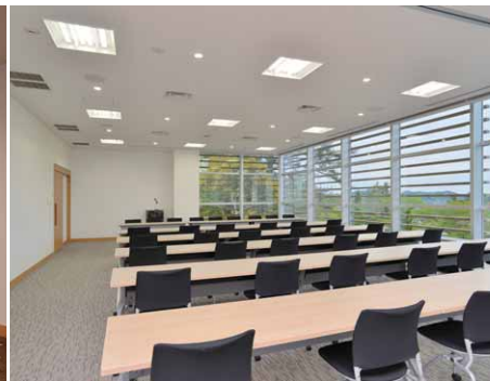
会議室の照明 一体形LEDベースライトスクエアタイプ+LEDライトエンジンダウンライト調光タイプ
