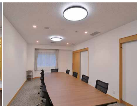
控室に採用したLEDシーリングライトとLEDライトエンジンダウンライト
