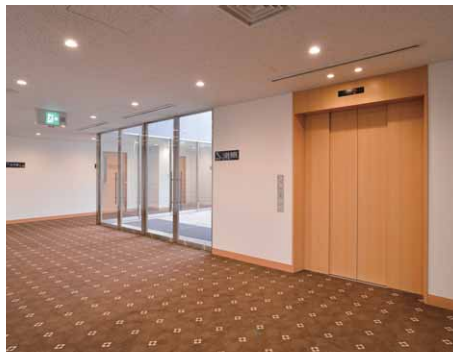
エレベーターホールのLED一体形ダウンライトによる照明
