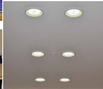
LED高天井用ダウンライトを2連パターンで配置
