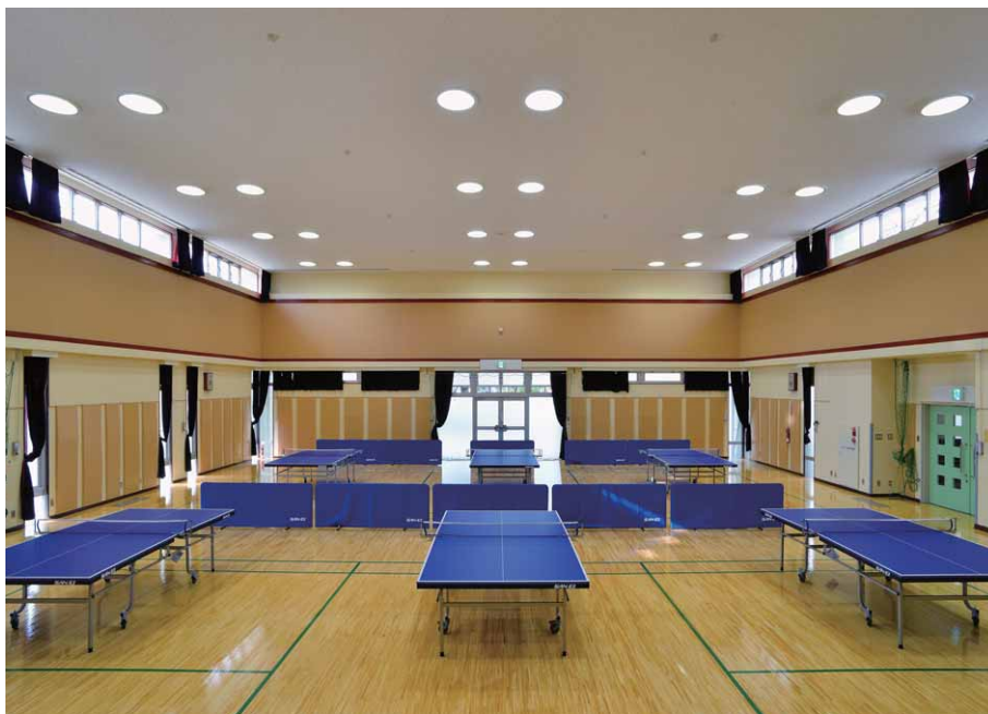
6台の卓球台を配置したホールの舞台側から入口方向を望む LED高天井用ダウンライトを2連のパターンで窓側・中央・内側に分け計36台を配置
