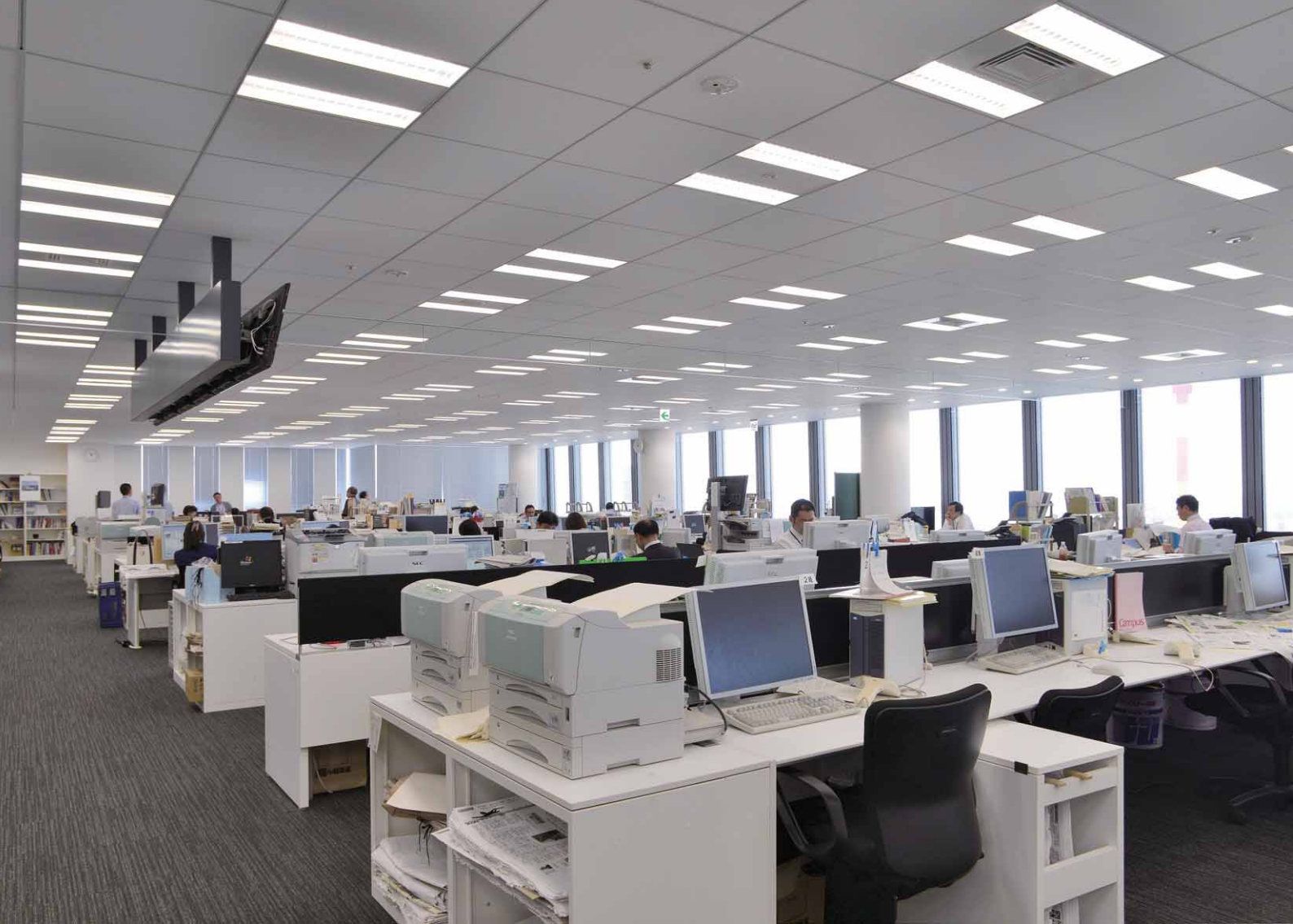
メディアフロアの執務室の照明 システム天井用LEDベースライトを均等配置。あかりセンサーとの連動による昼光利用制御で、適正照度を保ちながら省エネを実施
