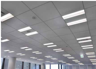
システム天井用LEDベースライトを配置した天井面
