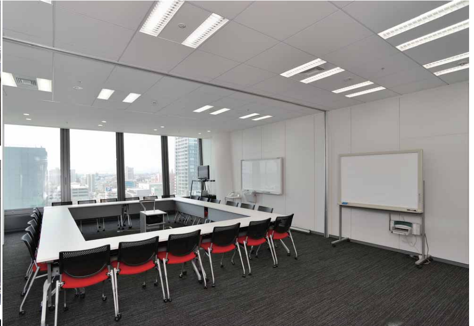
会議室のシステム天井用LEDベースライト。あかりセンサー十人感センサーで無駄な明るさをカットしてさらなる省エネ
