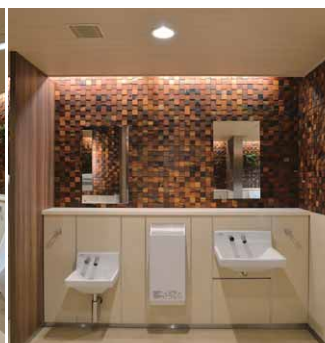
男性トイレの洗面所のLED照明
