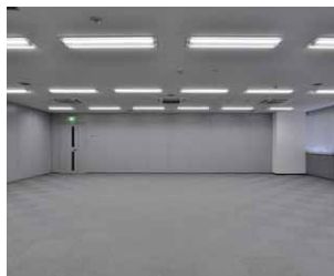
システム天井用リニューアルプレート＋一体形LEDベースライト薄形タイプに更新した5階執務フロア
