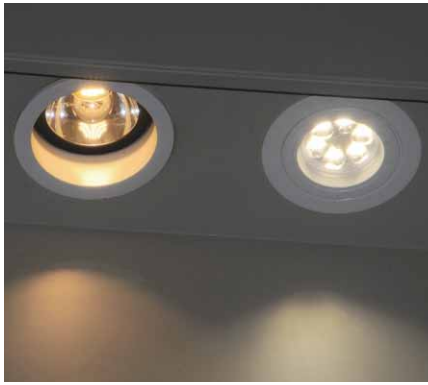
音響反射板ライト電球色(左)とLEDダウンライト昼白色(右)
