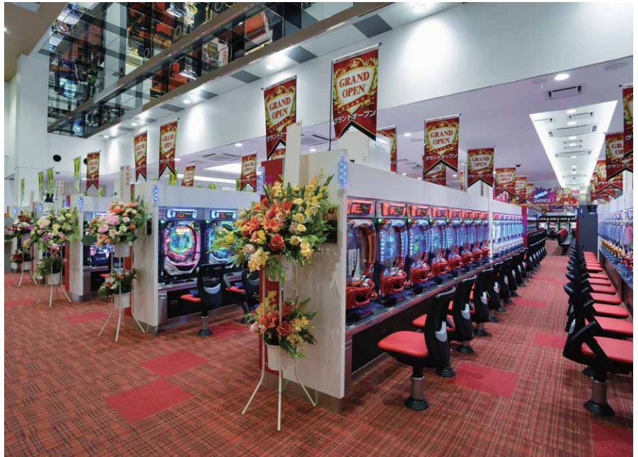
出入口周辺の高天井部にはLEDダウンライト9000シリーズを、遊戯ホール内は同器具6000シリーズを配置
