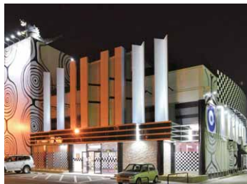
LED小形投光器による外観照明の様子
