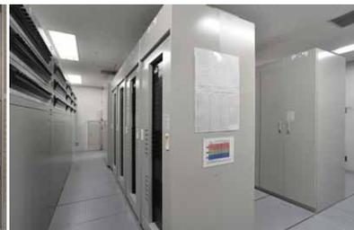
調光盤室においてA系統、B系統の電源をユニットごとに切り替え可能な調光器盤
