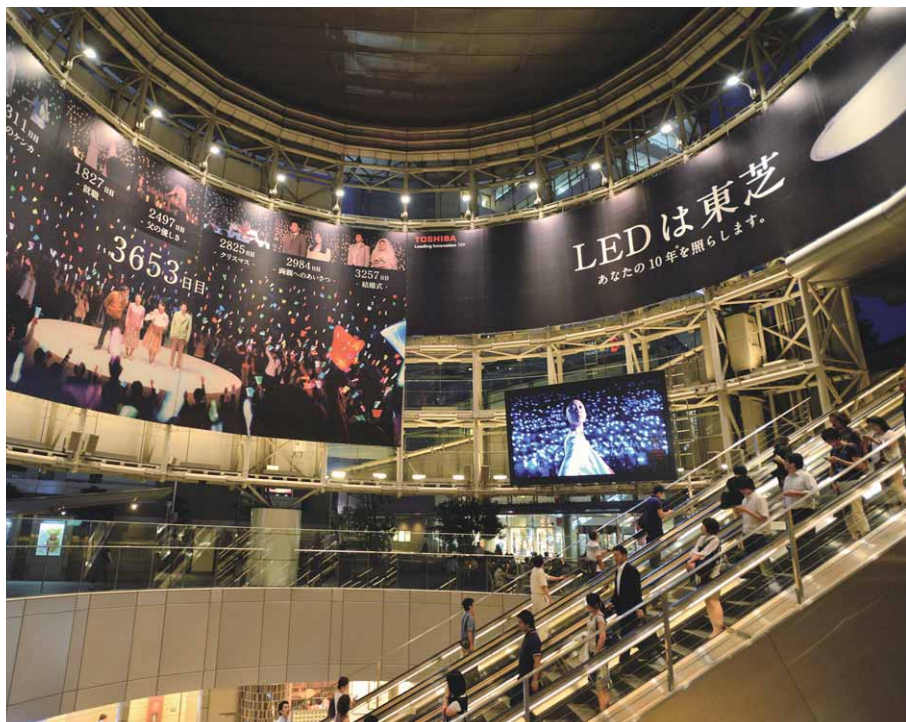
器具光束4,230lmのLED小形投光器狭角形を2.7m間隔で計24灯を均等配置
