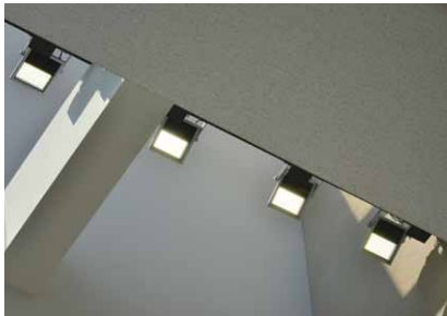
吹抜空間に採用した小形LED投光器
