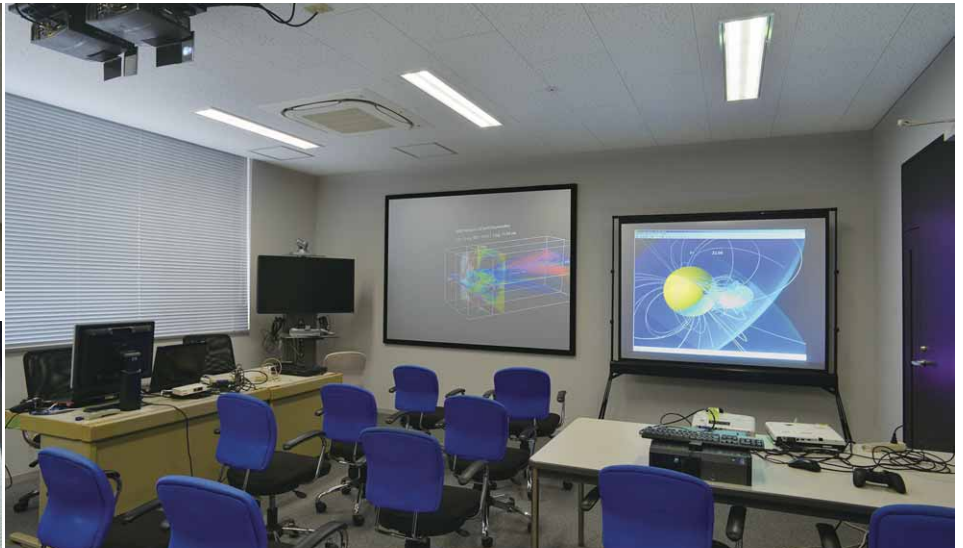
一体形LEDベースライト埋込ストレートタイプバップル付を採用した解析室の照明
