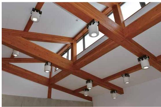
天井梁に千鳥配置で設置したLEDバンクライト
