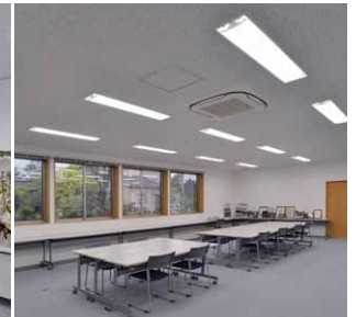
直管形LEDベースライトを採用したクラブハウスの会議室
