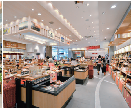
LEDダウンライト温白色を設置した下がり天井部
