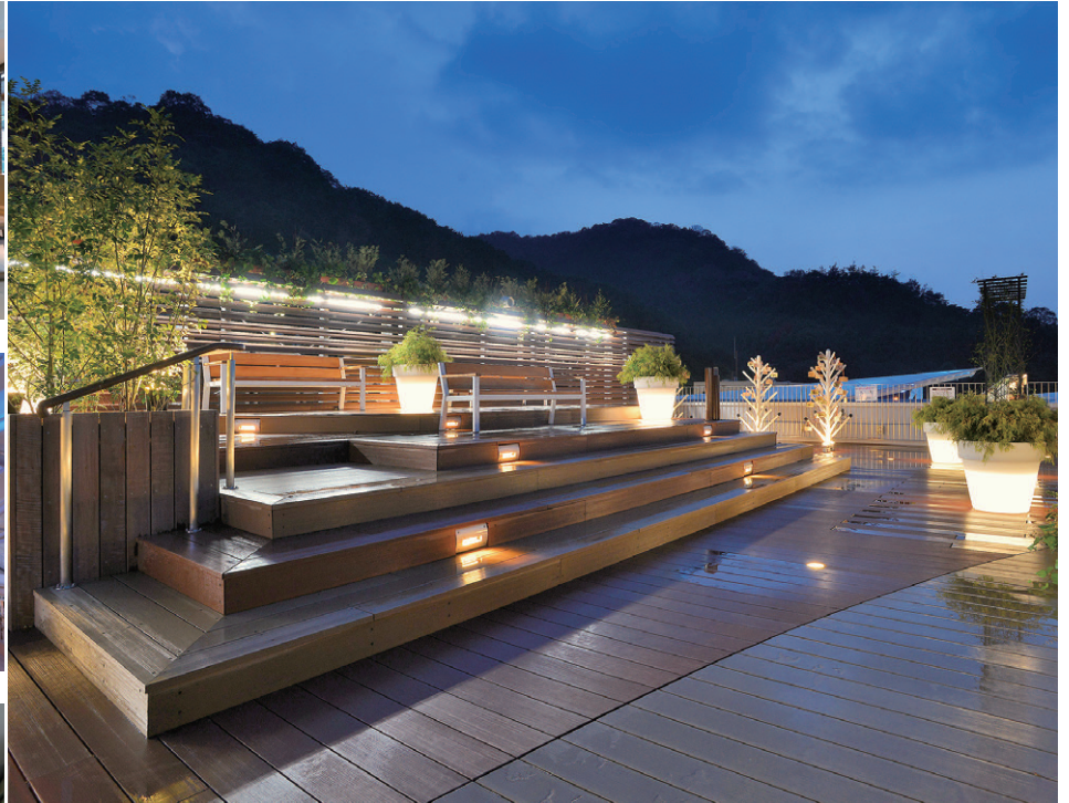
展望デッキの照明は、階段にはLEDフットライト、奥のルーバー形状の壁面に直管形LEDベースライト直付形を採用
