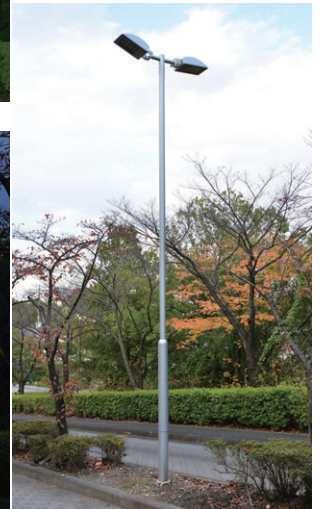
6m高の特注ポールにLED街路灯2台の器具を配備
