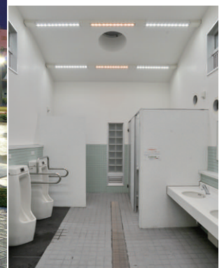
トイレはLEDライン器具を人感センサーにて点灯
