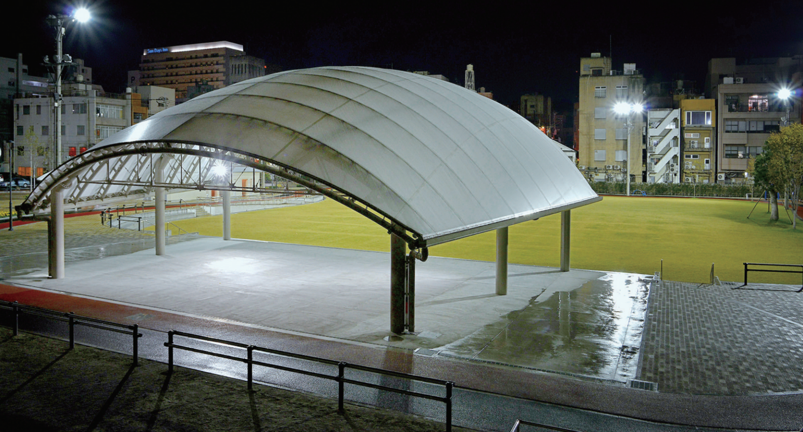
LED投光器で透過した屋根付シェルターを手にして、LED投光器で明るさが確保された天空広場を望む
