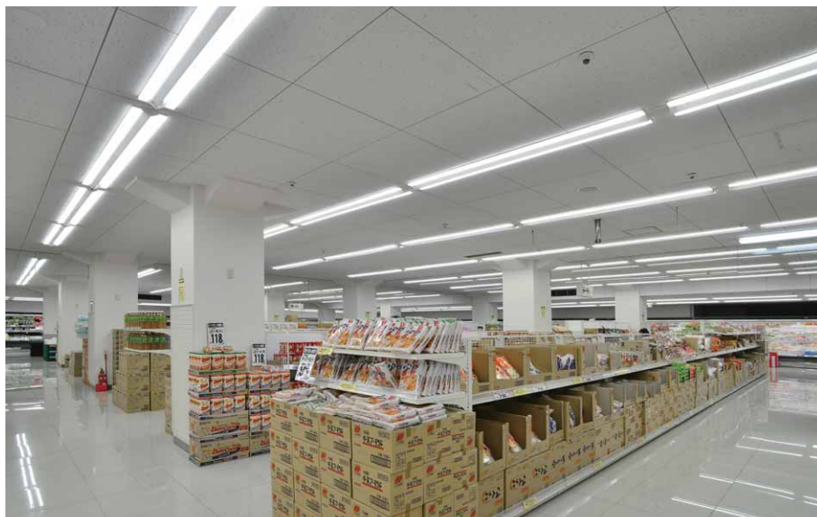
既存の蛍光灯器具を一体形LEDベースライト薄形タイプに更新し、空間全体に明るさ感と広がり感を創出
