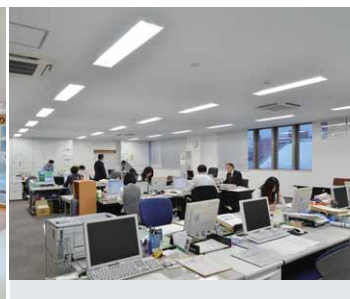
直管形LEDベースライトを採用した執務室の照明
