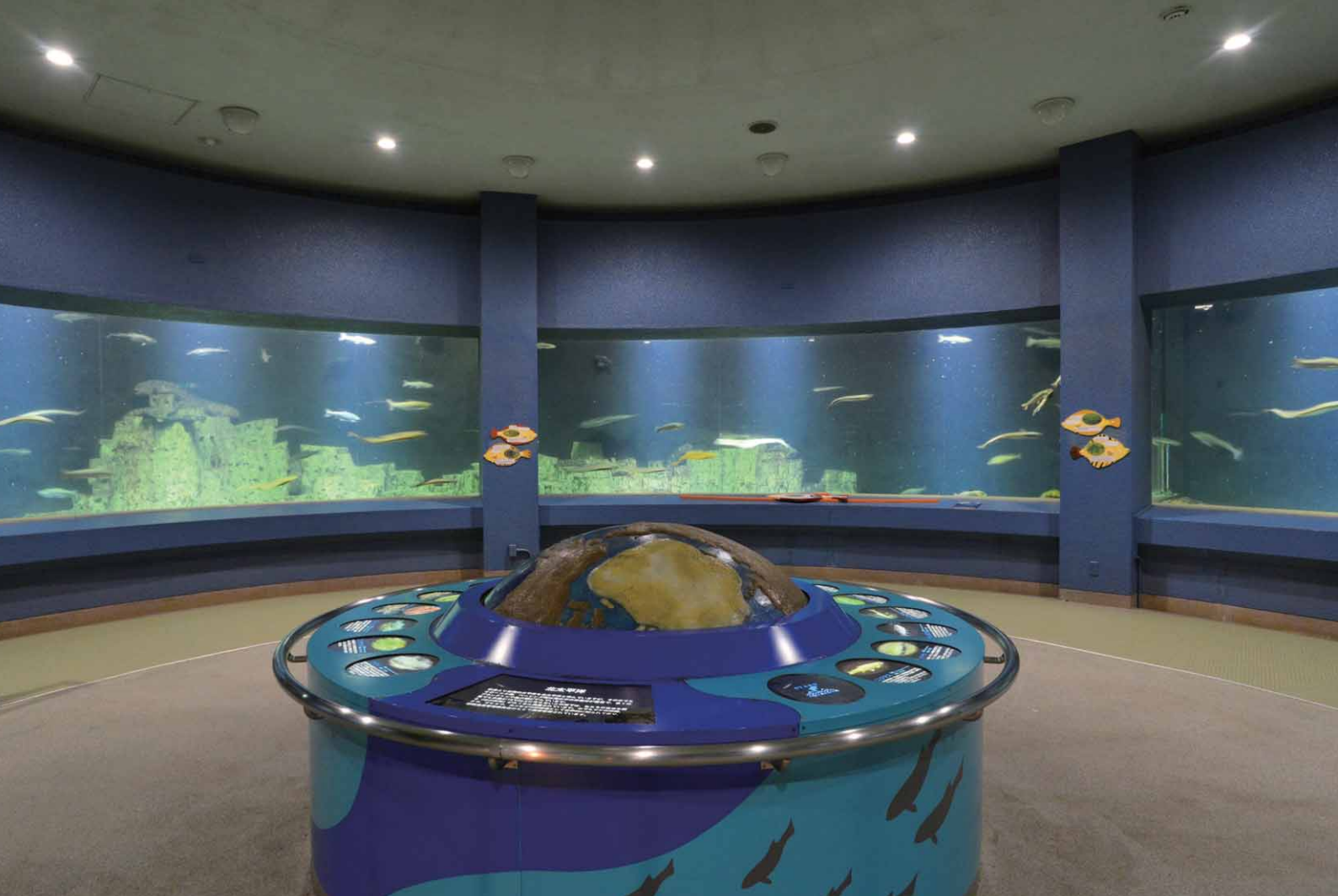
360度ぐるりと見渡せる「オホーツク海・ベーリング海の魚たち」のLED照明 水槽上部からはLED投光器、観覧通路にはLED電球形ダウンライトを配置
