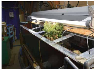
水槽上部に設けた直管形LEDベースライト反射笠器具
