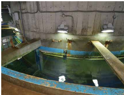
水槽上部に設置した平均消費電力210W形LED投光器
