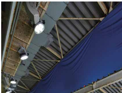
プール上部に設置した400Wメタルハライドランプ相当のLED投光器
