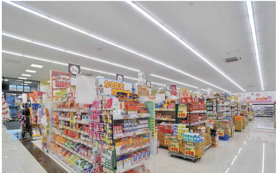
日用品・食料品売場の照明 LEDベースライト直付形AQシリーズを連結設置。陰が目立ちにくい美しいシームレスラインを形成
