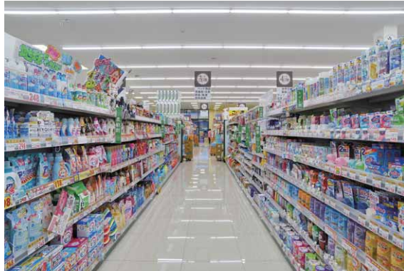
LEDのAQシリーズをゴンドラと直角にして配置
