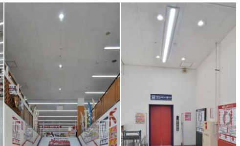
階段天井部のLEDダウンライト
