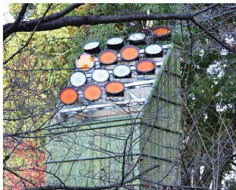
取付け架台の周囲を竹細工で覆った北西部分の器具設置状況
