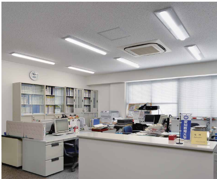
本部棟秘書広報課執務室に設置されたLEDベースライトAQシリーズ直付形
