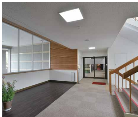
階段ホールに採用したLEDベースライト埋込形スクエアタイプ
