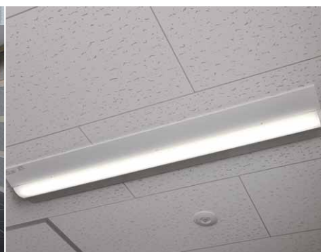
本部棟主照明のLEDベースライトAQシリーズ直付形
