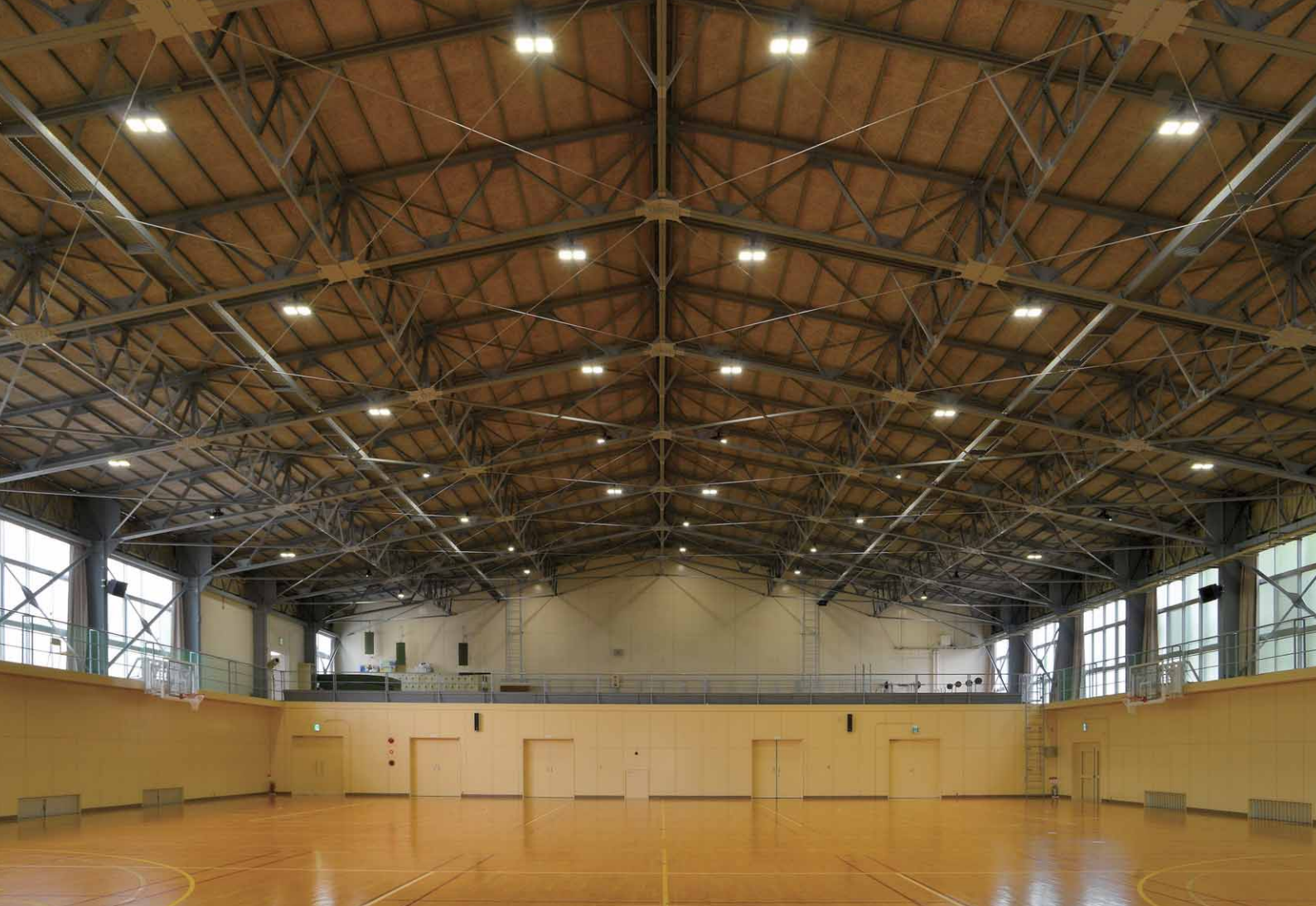
体育館に左右対象配置で採用された400W形LED高天井器具を正面側から2階のトレーニング室側方向を望む
