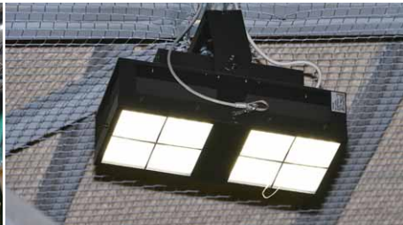
体育館の400W形LED高天井器具設置の様子
