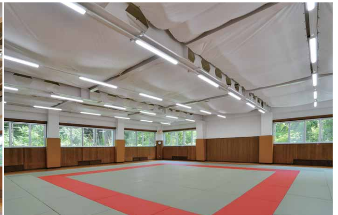
テントで覆った天井の梁に設置した柔道場のLEDベースライトAQシリーズ
