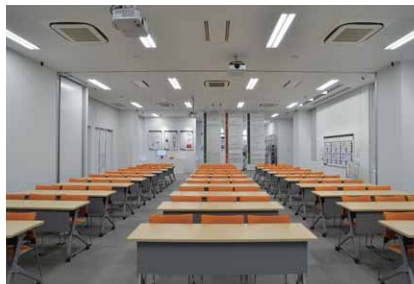
1階減災ホールの一体形LEDベースライト埋込ストリートタイプによる照明
