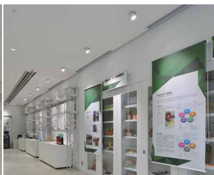
壁面コーナーのLEDダウンスポットによる照明
