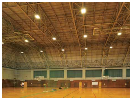
体育館を側面から望むLED高天井器具
