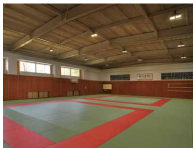
武道館に採用された400W形LED高天井器具
