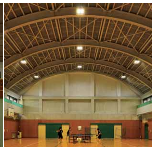
更新した第二体育館の1kW形LED高天井器具の様子
