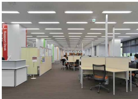
2階の多目的ラーニングエリアの直管形LEDベースライト埋込形による照明
