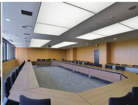
5階大会議室の照明。光天井内には一体形LEDベースライト直付形1灯を列状に配置
