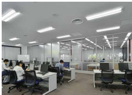
2階のセミナールームの一体形LEDベースライト薄形タイプによる照明
