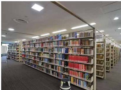
全フロア、広いスペースを占める書架の照明には人感センサー+LED照明でこまめにON/OFF制御
