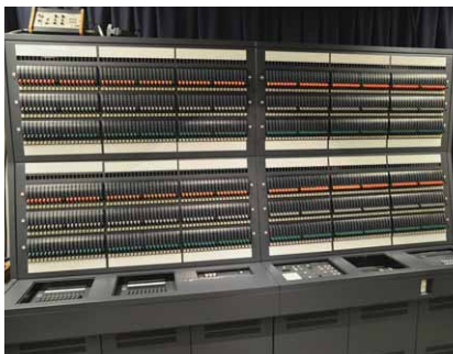
大劇場のプリセットフェーダ盤 240本×3段の立盤タイプで太鼓型フェーダを採用
