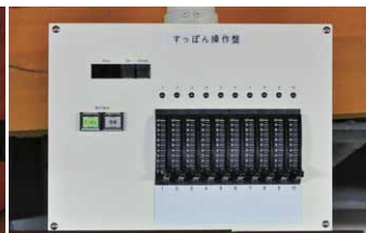
花道の舞台寄りにある小さなセリ(すっぽん)を使用する際に照明操作を行う、すっぽん操作盤
