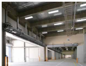
トラックパースには防湿・防雨タイプの直管形LED反射笠器具を採用
