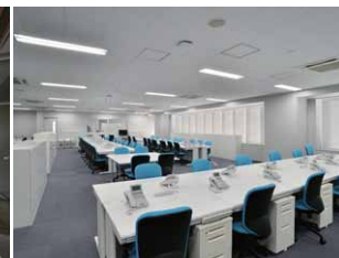
LEDベースライト埋込形器具を採用した事務所
