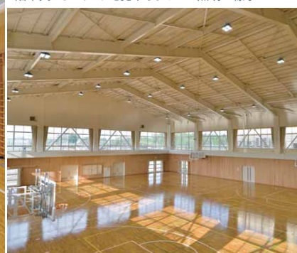
2階舞台方向左側から奥側右方向を望む
