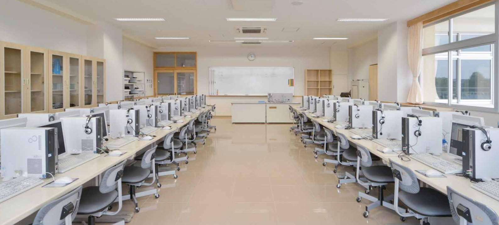
直管形LEDベースライト埋込下面ルーバ付を採用し、目の健康を配慮しつつ快適な光環境を確保しているパソコン室
