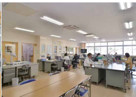
一体形LEDベースライト薄形タイプ使用の職員室の照明
