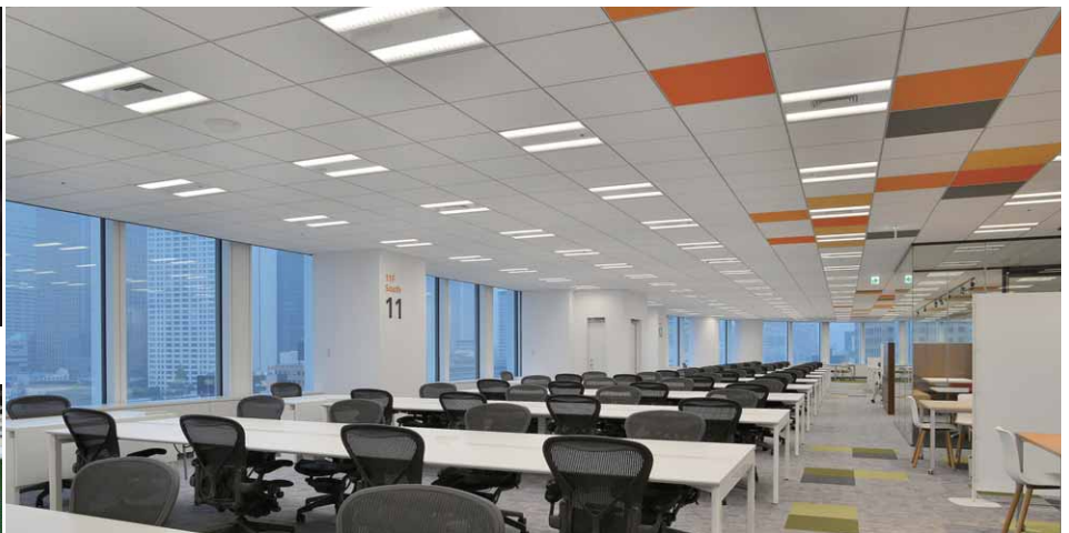
LEDシステム天井用グリッド照明器具を均等配置したオフィスフロア
