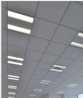
省電力照明制御システム MESHにより昼光時は窓側器具の照度を自動制御
