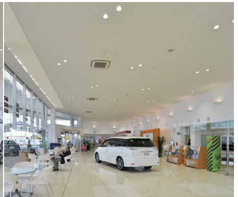
ガラスウォールに沿って配置された直管形LEDベースライト笠なし器具による間接照明
