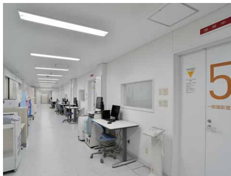
「C棟」LEDベースライトパツフル付埋込形を採用したX線操作室
