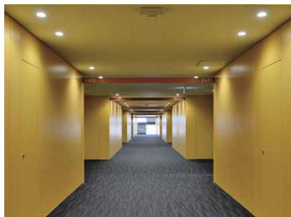
「C棟」廊下に採用されたLEDライトエンジンダウンライト
