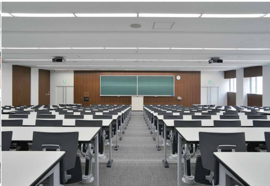
「A棟」大講義室のLEDベースライトによる照明
