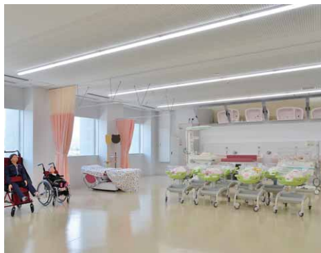
「C棟」LEDベースライトをライン配置した母性・小児看護学実習室
