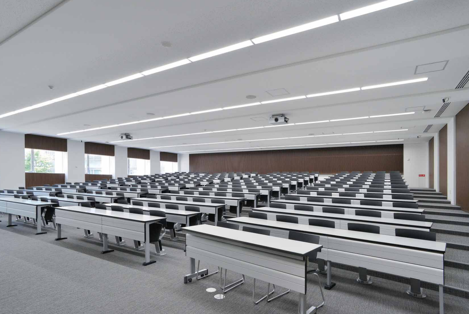
「A棟」大講義室のLEDベースライトライン配置による照明。スッキリとしたスリムな形状で天井面にも光がまわり、空間全体の広がり感が創出
