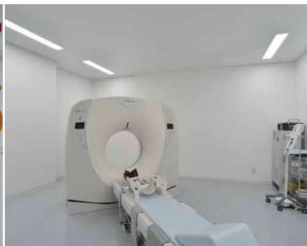
「C棟」CT室のLEDベースライト埋込形器具
