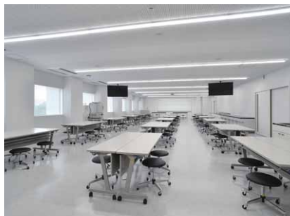
「C棟」医用画像情報学実習室のLEDベースライトによる照明
